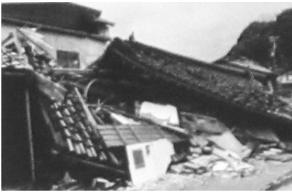
氷見市姿地区建物崩壊
